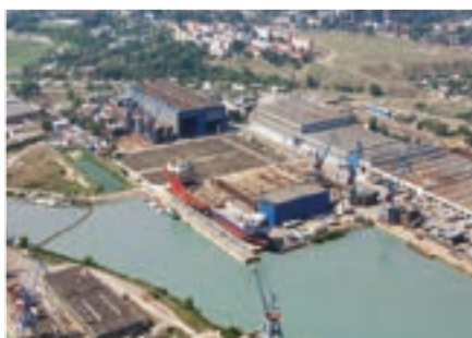
Brodogradilište STX-OSV, Tulčea, Rumunija
